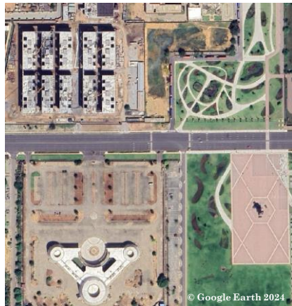
Image Google de Cotonou (Bénin) montrant le Palais des Congrès, la Place de l'Amazonie et la nouvelle Cité Ministérielle en construction.
